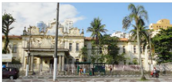
Figura 1 – Fachada do edifício antigo da Etec Dona Escolástica Rosa, em 2018. Fonte: Arquivo pessoal da autora, 2022.
