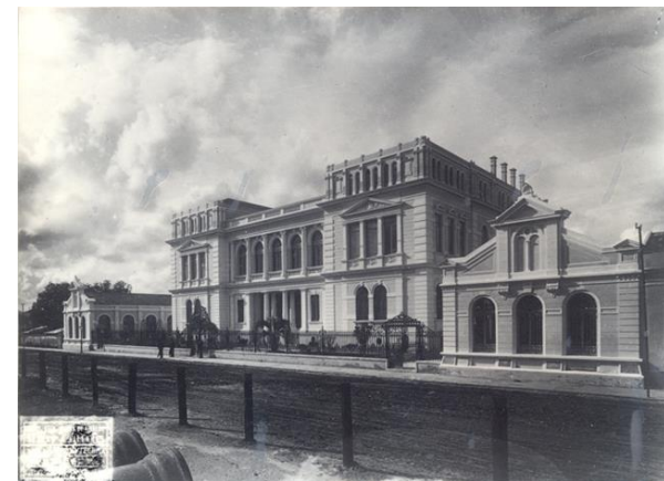
Fotografia Edifício Paula Souza da COLEÇÃO Ramos de Azevedo na FAU/USP Escola Politécnica, em 1937. Acervo da Biblioteca Central FATEC SP, em 2016
