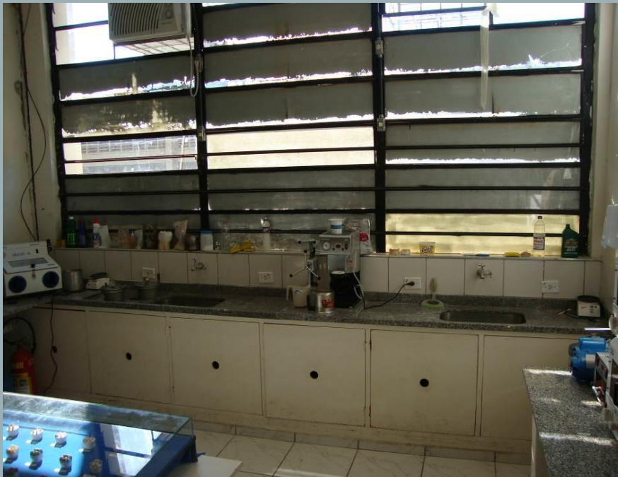
Antes da Reforma
