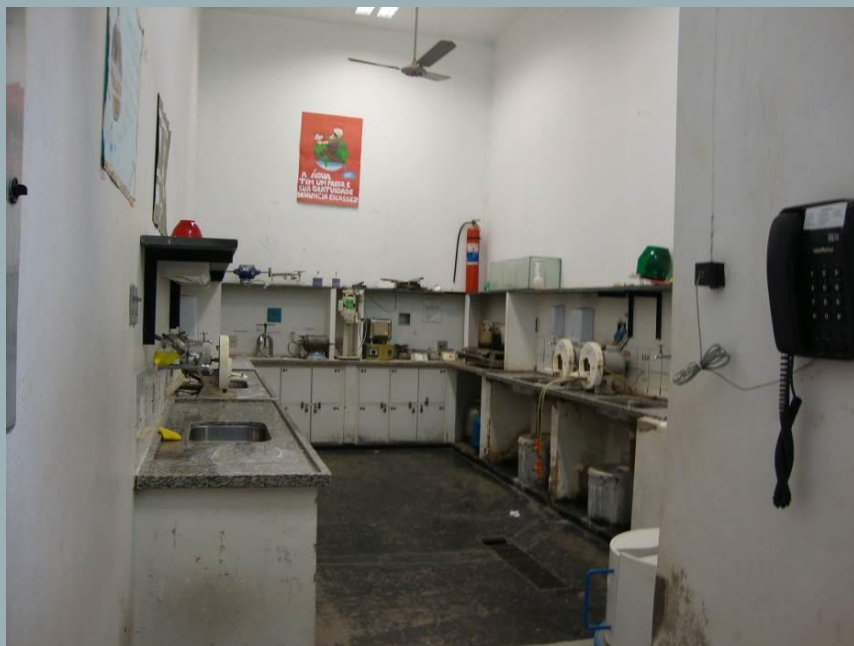
Antes da Reforma
