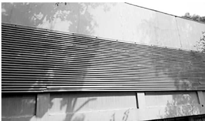
**Figura 6** – Defletores de calor instalados sobre as janelas.
