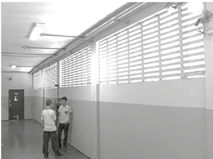
**Figura 5** – Corredor com elementos vazados.
