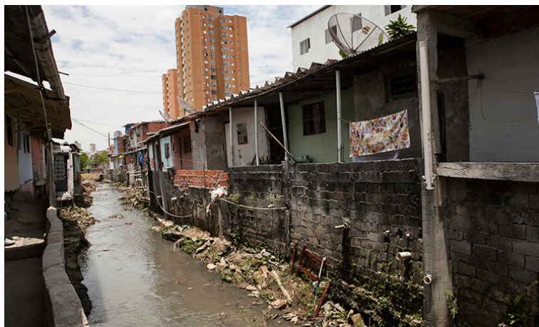
Rua sem rede de esgoto
